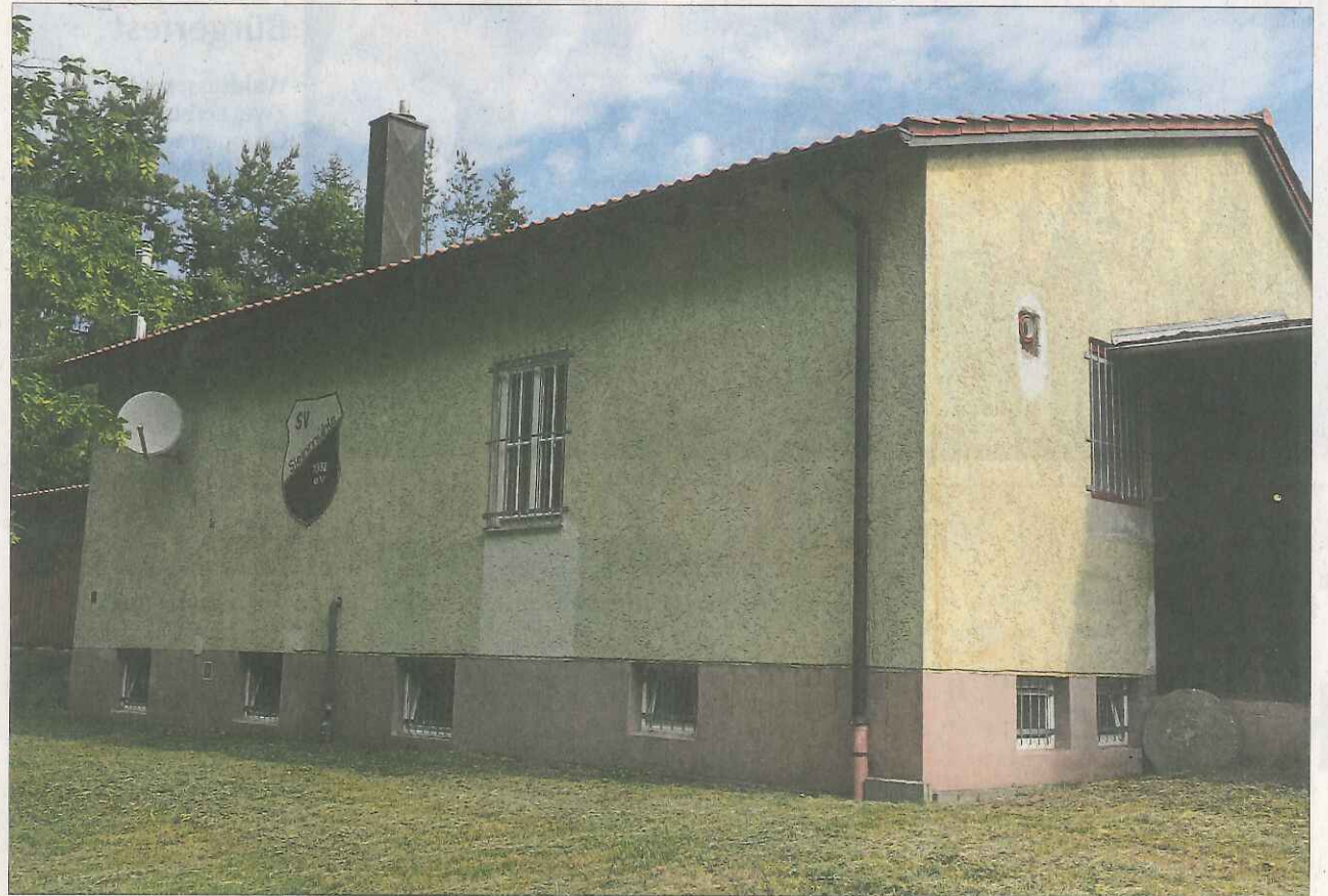
Hier an der Rückseite des SV-Sportheims soll auf einer Fläche von 13 mal 5 Metern ein Anbau entstehen. Dadurch lässt sich die Gastwirtschaft auf dann 110 Sitzplätze erweitern. Bild: jr
