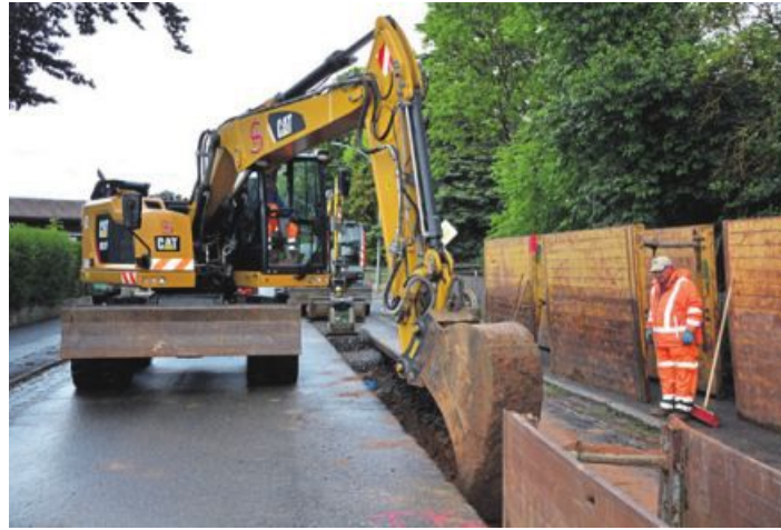
Die Bauarbeiten liegen nach Auskunft des Tiefbauunternehmens Schaumberger im Zeitplan, „wir kommen zügig voran“, war zu hören. (jr) Bild: jr
