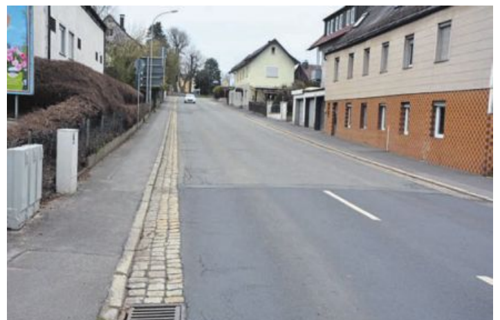
In der Wiesauer Straße werden die Wasser- und Abwasserleitungen für 2,65 Millionen Euro komplett erneuert. Die Arbeiten sollen demnächst beginnen und noch heuer fertiggestellt werden. (jr) Bild: jr
