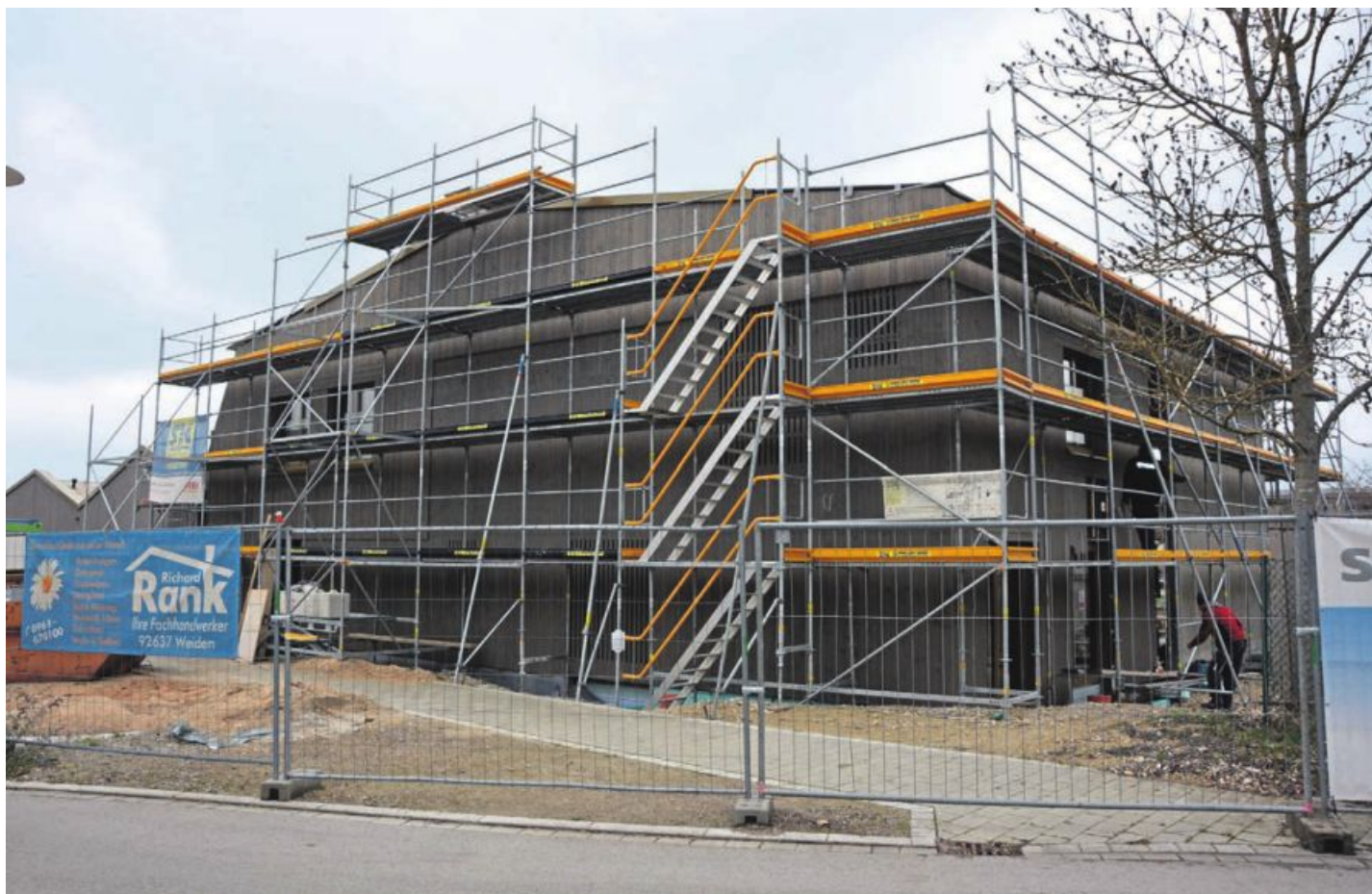
Noch heuer fertiggestellt werden soll der Anbau an das Kinderhaus „Purzelbaum“, im Haushalt sind weitere 2,5 Millionen Euro eingeplant. (jr) Bild: jr
