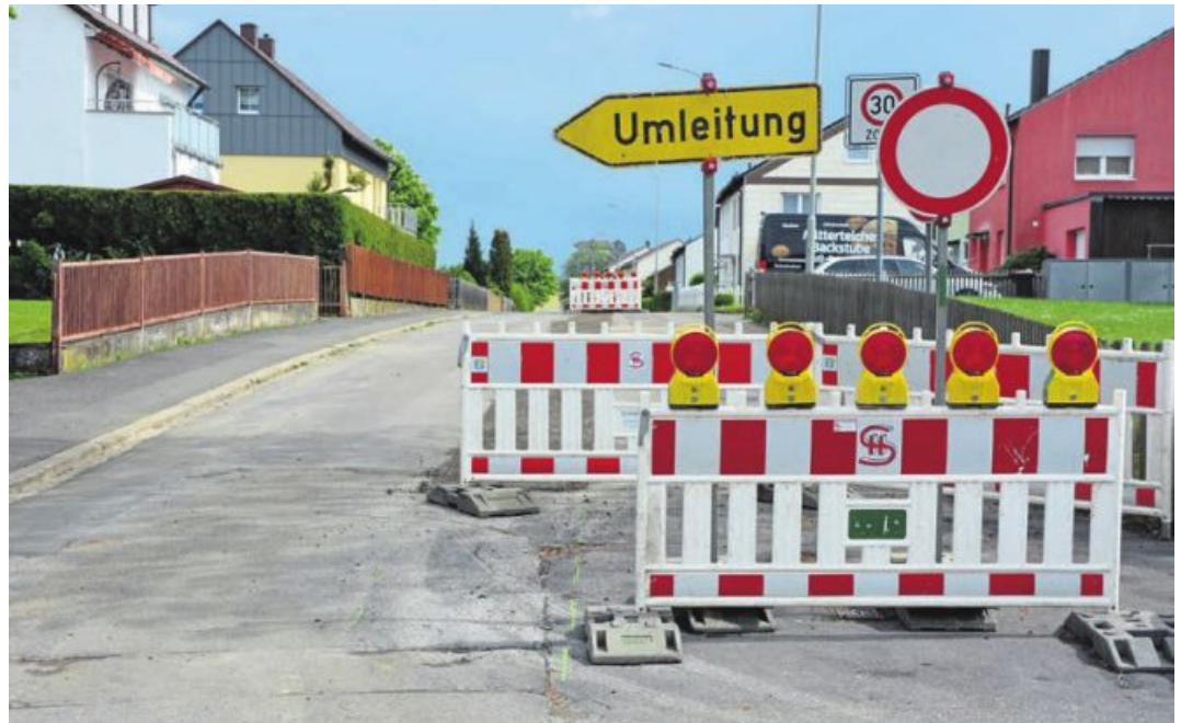
Erste Arbeiten haben auch in einem Teilabschnitt der Wiesenstraße begonnen. (jr)
