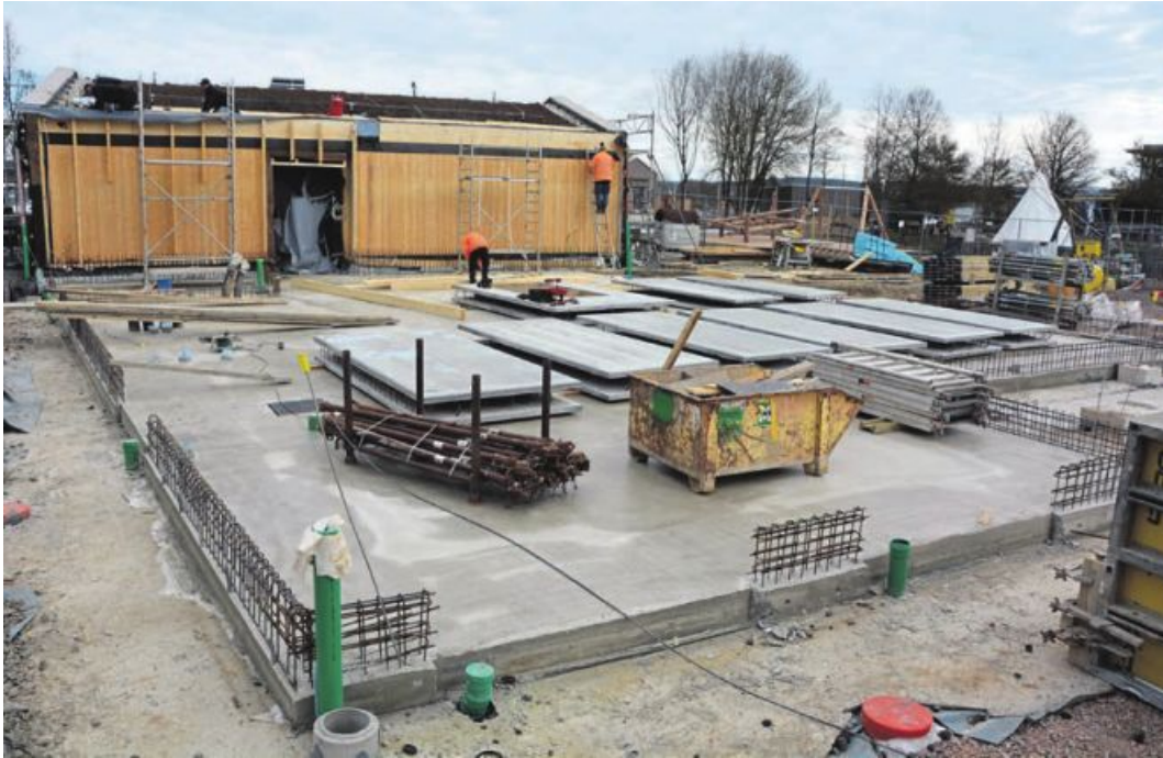
Im Bild die Baustelle des Erweiterungsbau Kinderhaus „Purzelbaum“, an dem die Stadt heuer mit Kosten von 1,5 Millionen Euro beteiligt ist. Bild: jr
