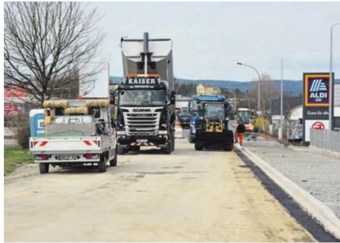
Kürzlich fanden in der Carl-Zeiss-Straße Asphaltierungsarbeiten statt. Bild: jr
