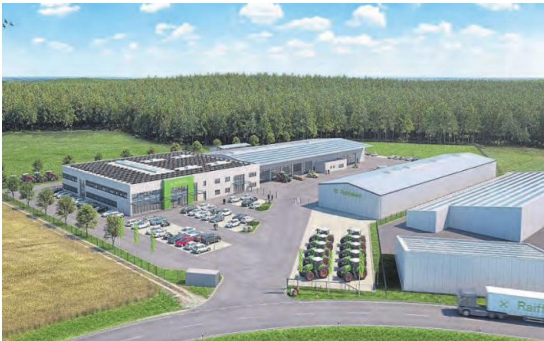
So soll künftig das Areal des Raiffeisen Landtechnik-Zentrum in Mitterteich aussehen. Gut zehn Millionen Euro investiert hier die Raiffeisen Waren GmbH Nordoberpfalz in den neuen Standort.
