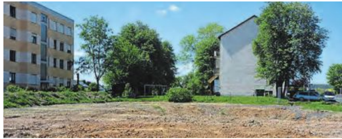
Bald beginnen sollen die Bauarbeiten an einem neuen Wohnblock in der Wiesstraße, 18 Wohnungen sollen hier neu entstehen. Bild: jr
