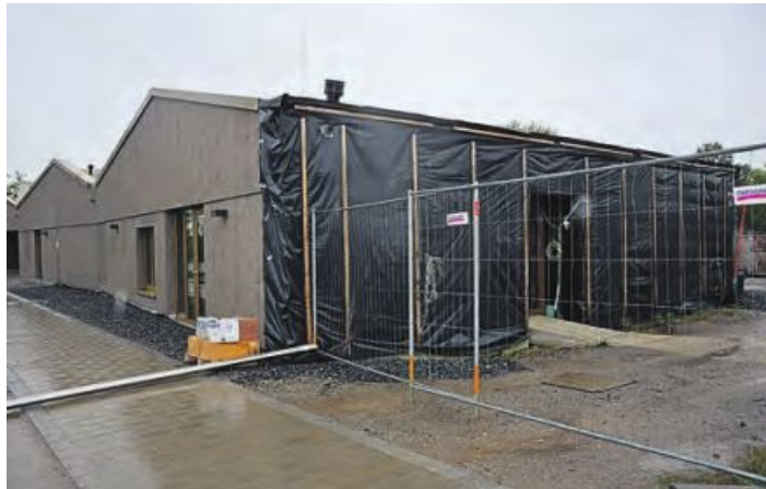
Noch heuer im Herbst soll der zweigeschossige Anbau für zwei Kindergartengruppen beim „Purzelbaum“ starten. Der Einzug ist für den Herbst 2025 geplant. Erste Kostenberechnungen gehen von 3,4 Millionen Euro aus. Bild: jr
