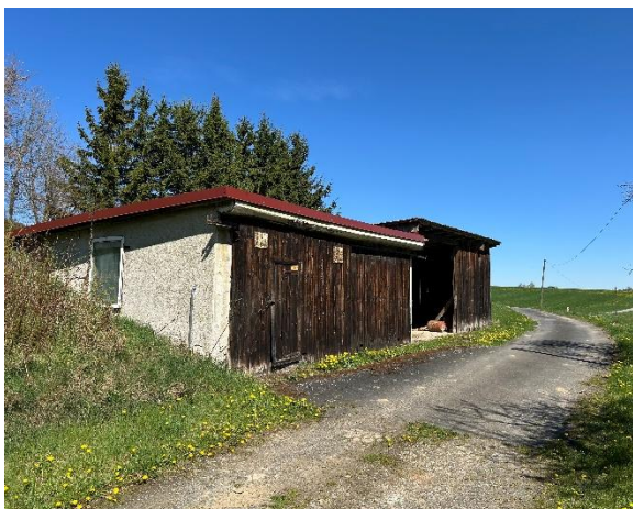
Werkstatt und Scheune
