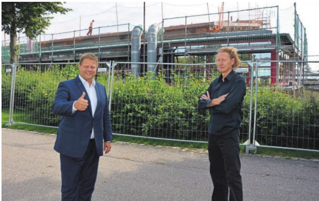
Bürgermeister Stefan Grillmeier (links) ist optimistisch, dass die Eishalle ab 7. Januar 2022 wieder den Eissportlern zur Verfügung steht. Mit vor Ort war auch Axel Kraus vom Bauamt der Stadt Mitterteich. (jr) Bild: jr
