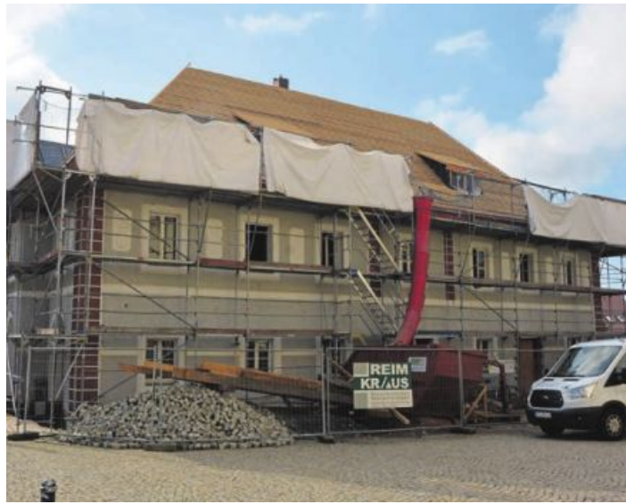
Noch immer eingerüstet präsentiert sich das Historische Rathaus in Mitterteich. Noch im September soll das Dach eine neue Biberschwanzeindeckung erhalten. Die Bauarbeiten werden wohl bis Ende des ersten Quartals 2022 noch in Anspruch nehmen. (jr) Bild: jr
