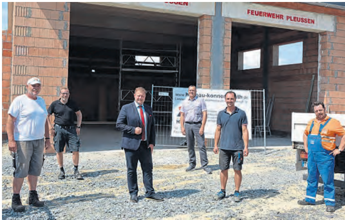
Die Verantwortlichen für den Neubau des Feuerwehrgerätehauses in Pleußen auf einem Bild, (von links) mit Maurermeister Willi Wenisch (HW-Bau), Vorsitzenden Markus Fischer, Bürgermeister Stefan Grillmeier, Bauamtsmitarbeiter und Projektbetreuer Thomas Siller, Kommandant Wolfgang Haberkorn und sein Stellvertreter Matthias Kastl. (jr) Bild: jr
